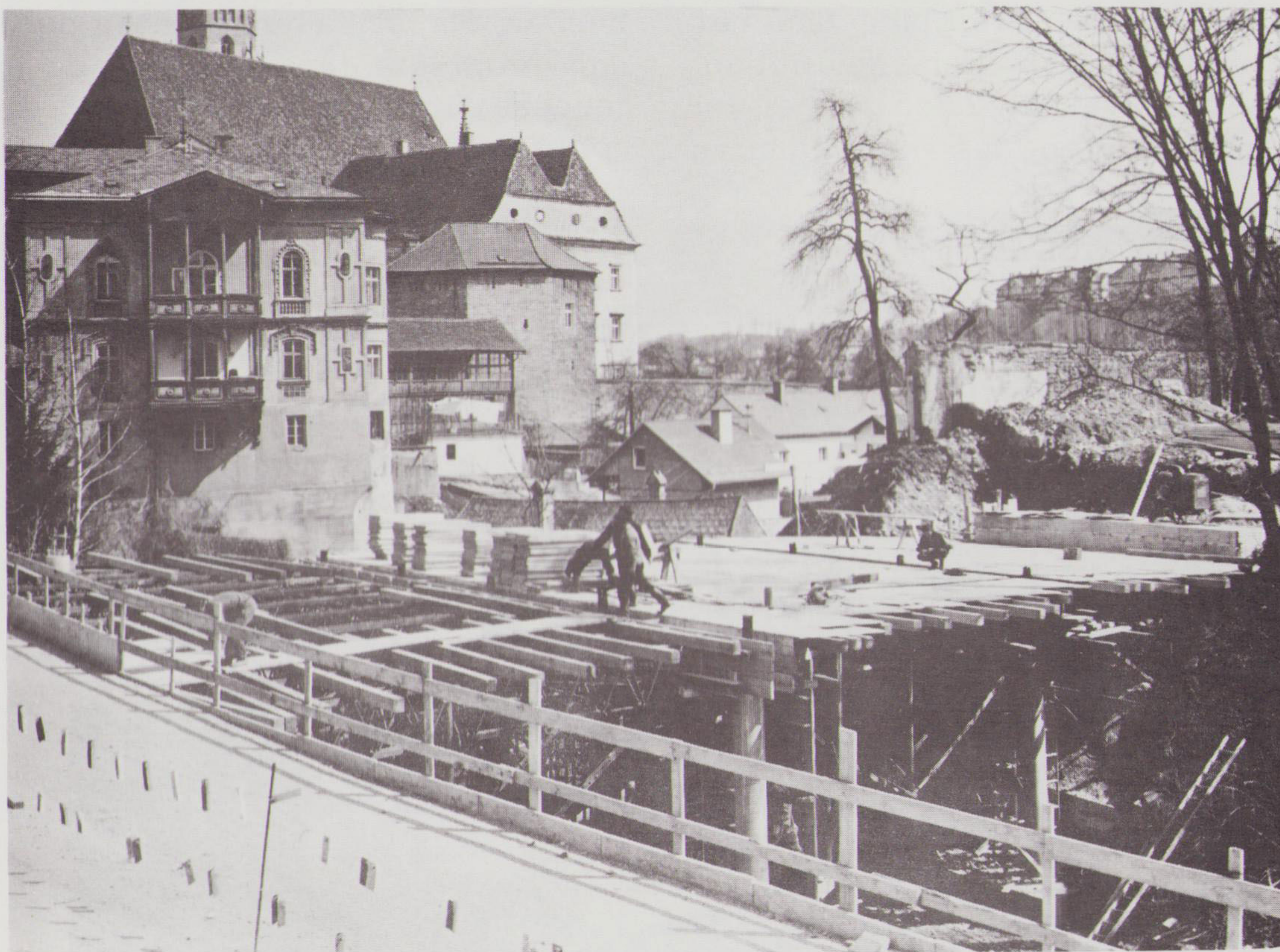
DER BAU DER NEUEN BRÜCKE ÜBER DIE ZIEGLERGASSE IST GEGENWÄRTIG IM GANG
