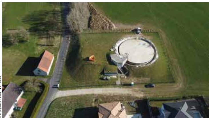
Der Hochbehälter an der Ostgrenze von Steyr in unmittelbarer Nähe des Alten- und Pflegeheimes Ennsleite wird derzeit saniert. Eine von zwei Wasserkammern ist auf dem Foto sichtbar.
