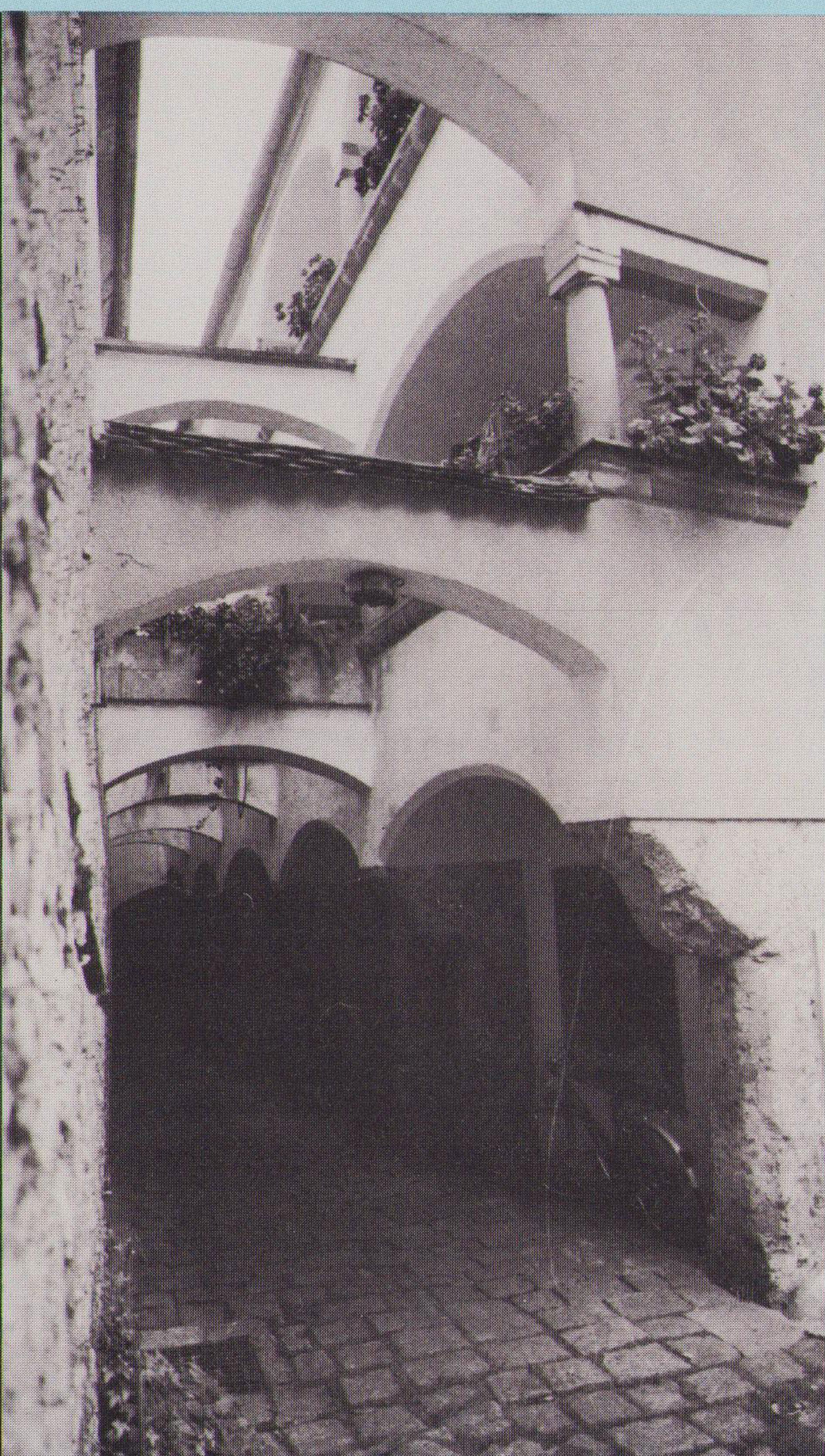
Hof im Haus Gleinker Gasse 4 mit Schwibbögen aus spätgotischer Zeit und toskanischen Säulen im Obergeschoß.
