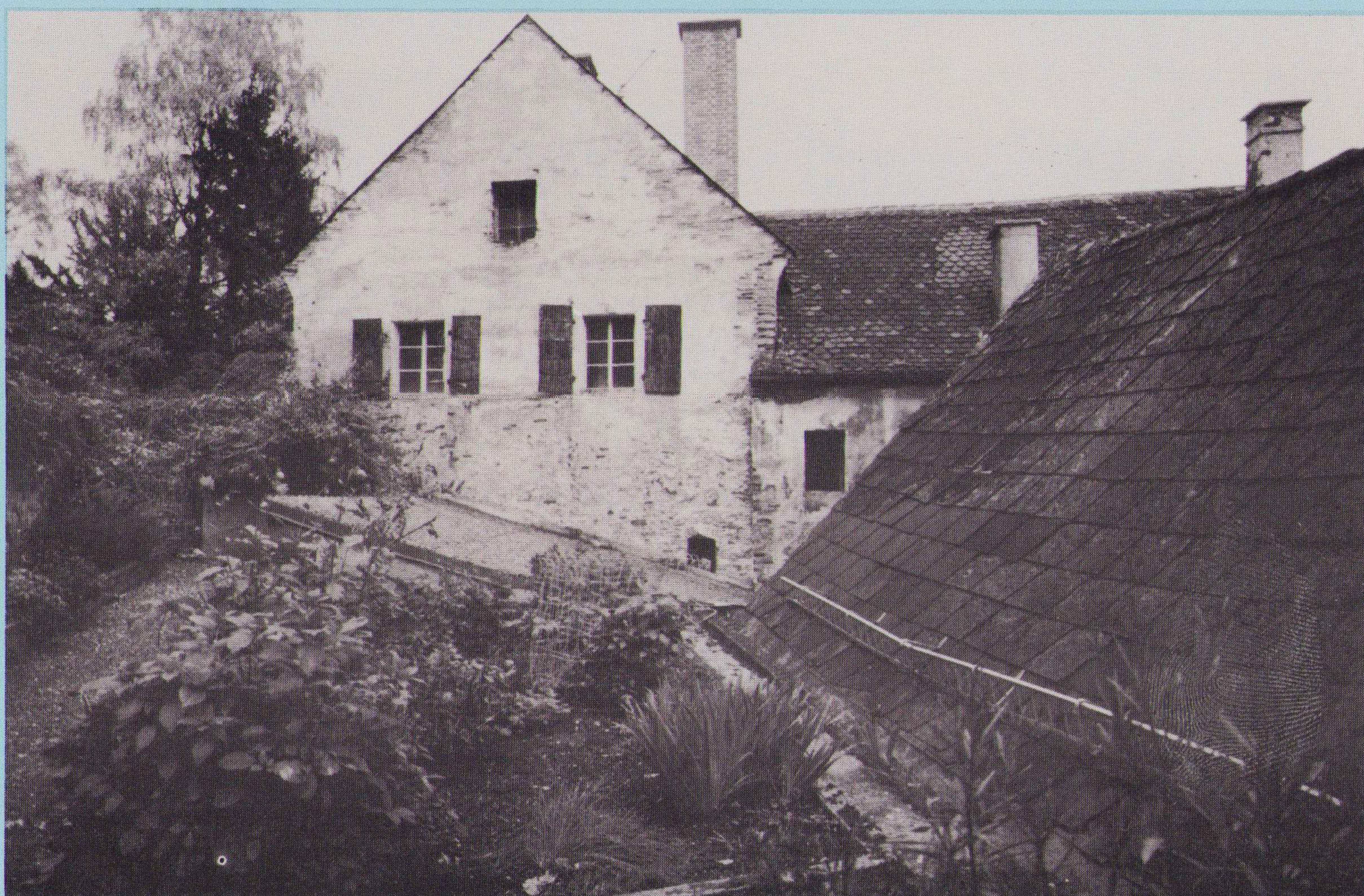
Die straßenseitig geschlossene Architektur der Kirchen- und Gleinker Gasse geht an der Hinterseite in das Grün des Taborhanges über.
