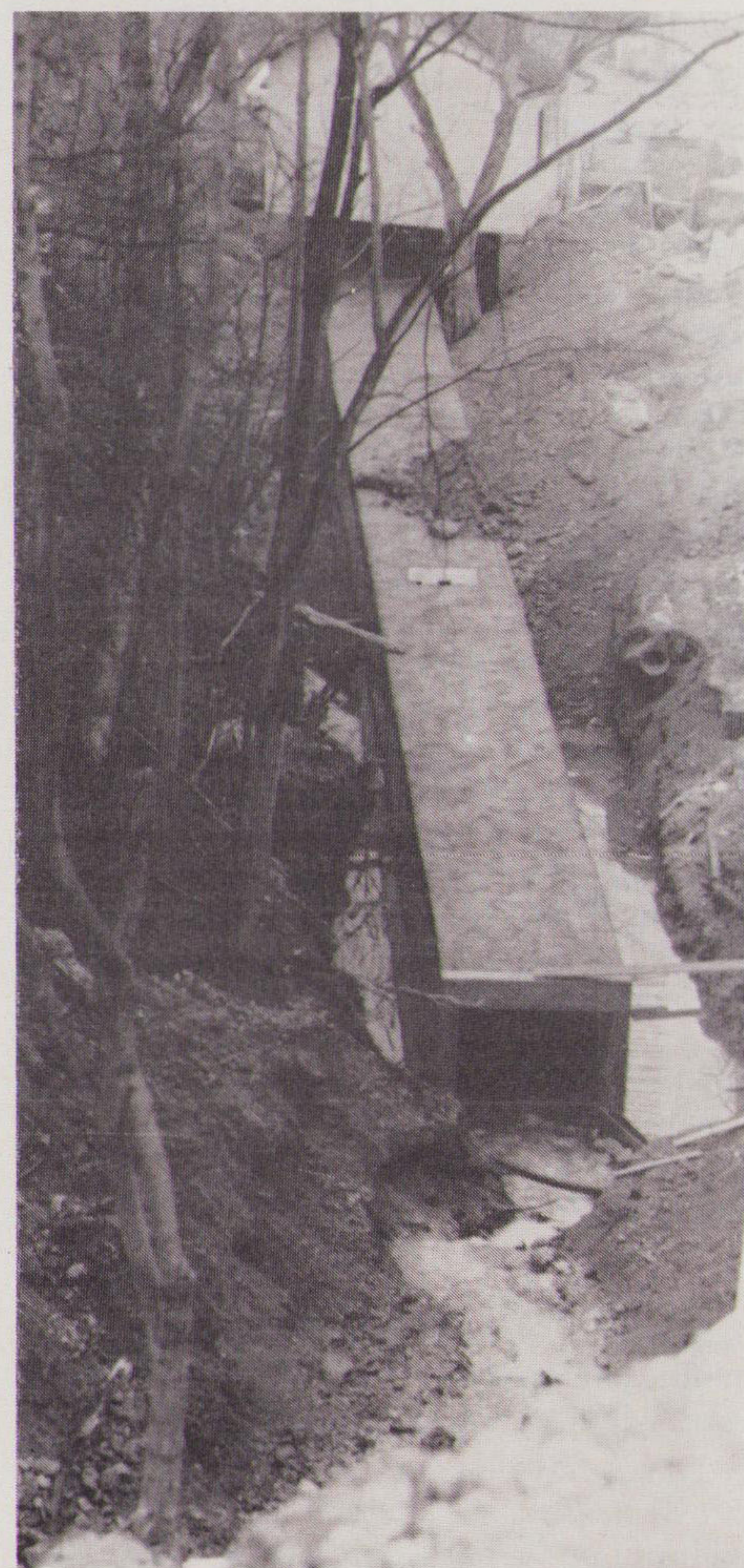
Der Unterlauf des Teufelsbaches mußte zur Herstellung der Fußgeherunterführung verrohrt werden.
