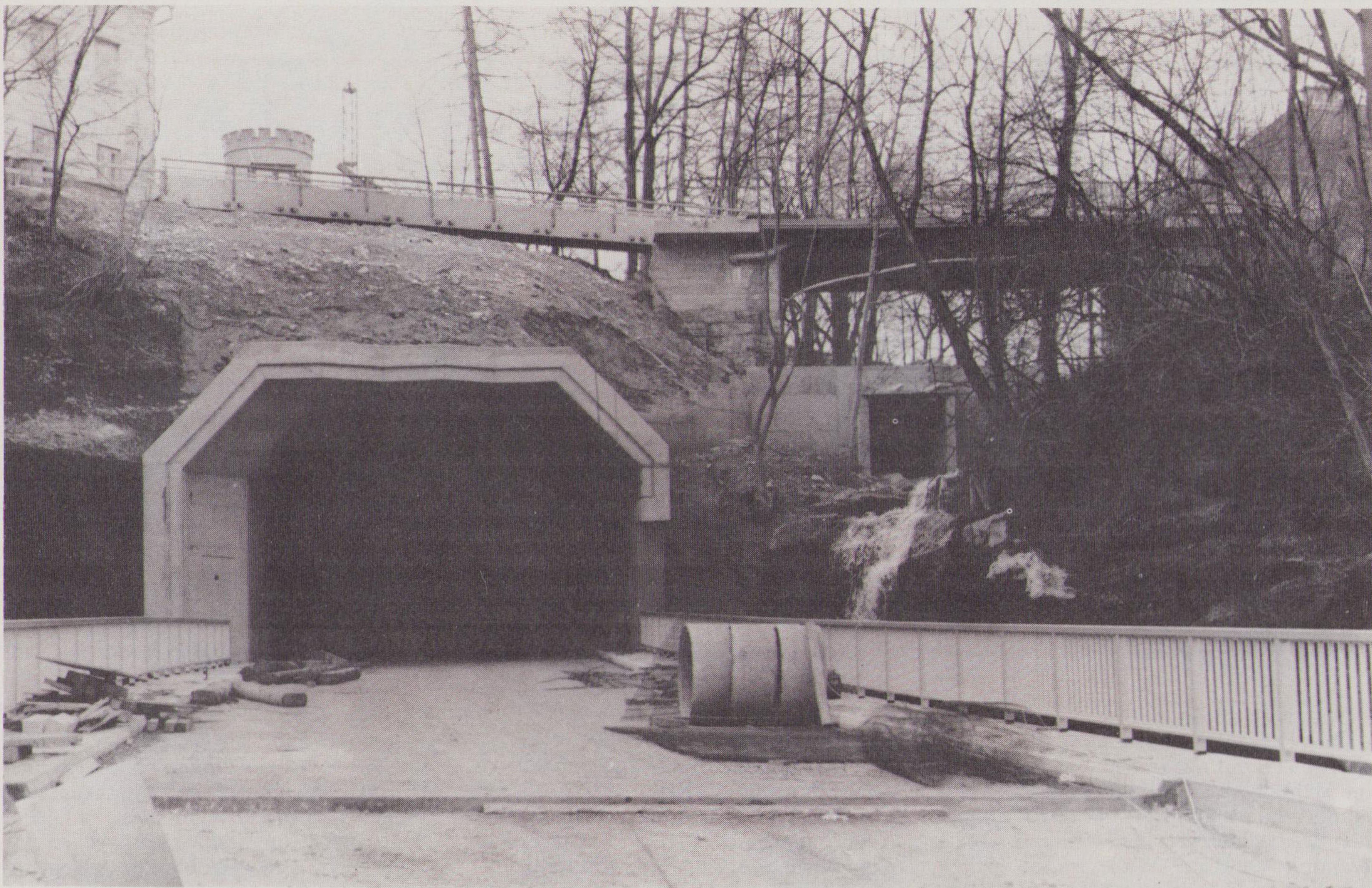
Rechts neben dem Nordportal des Tunnels der Auslaß des verrohrten Teufelsbaches. Das Wasser des Baches springt wie ursprünglich über den Felsen.
