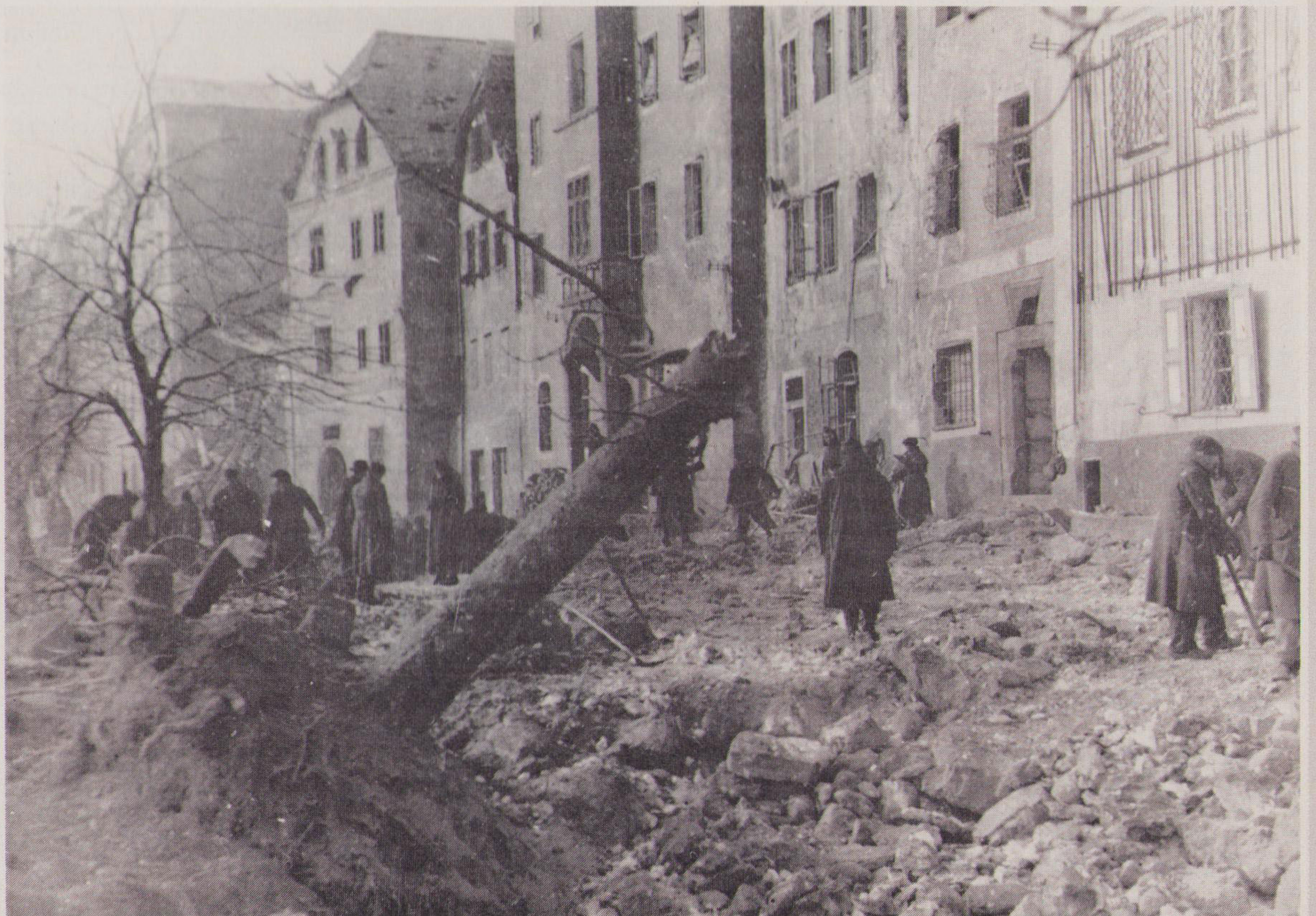
Aufräumarbeiten am Ennskai.
