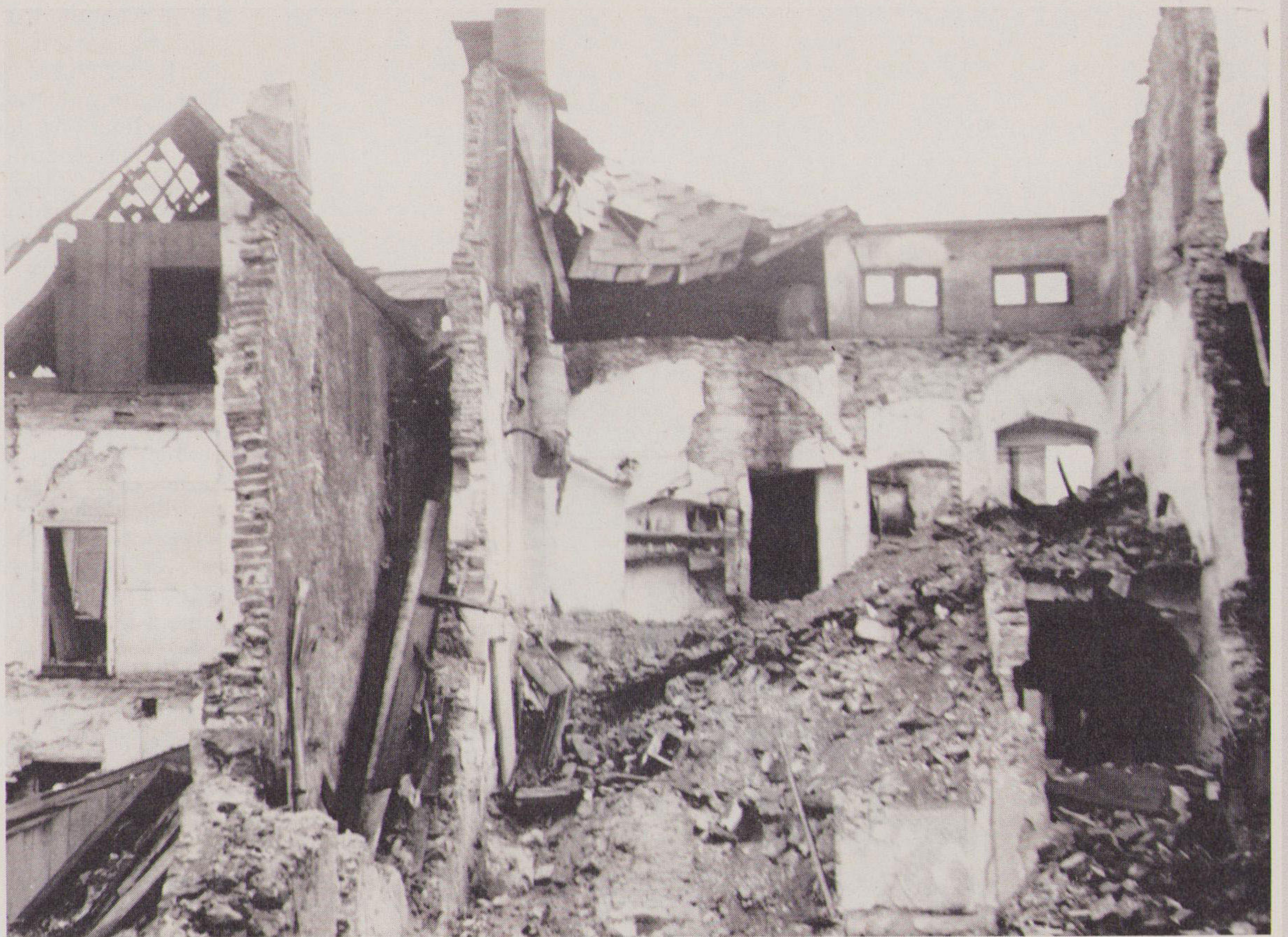
Zerstörte Häuser Enge 21 und 23
