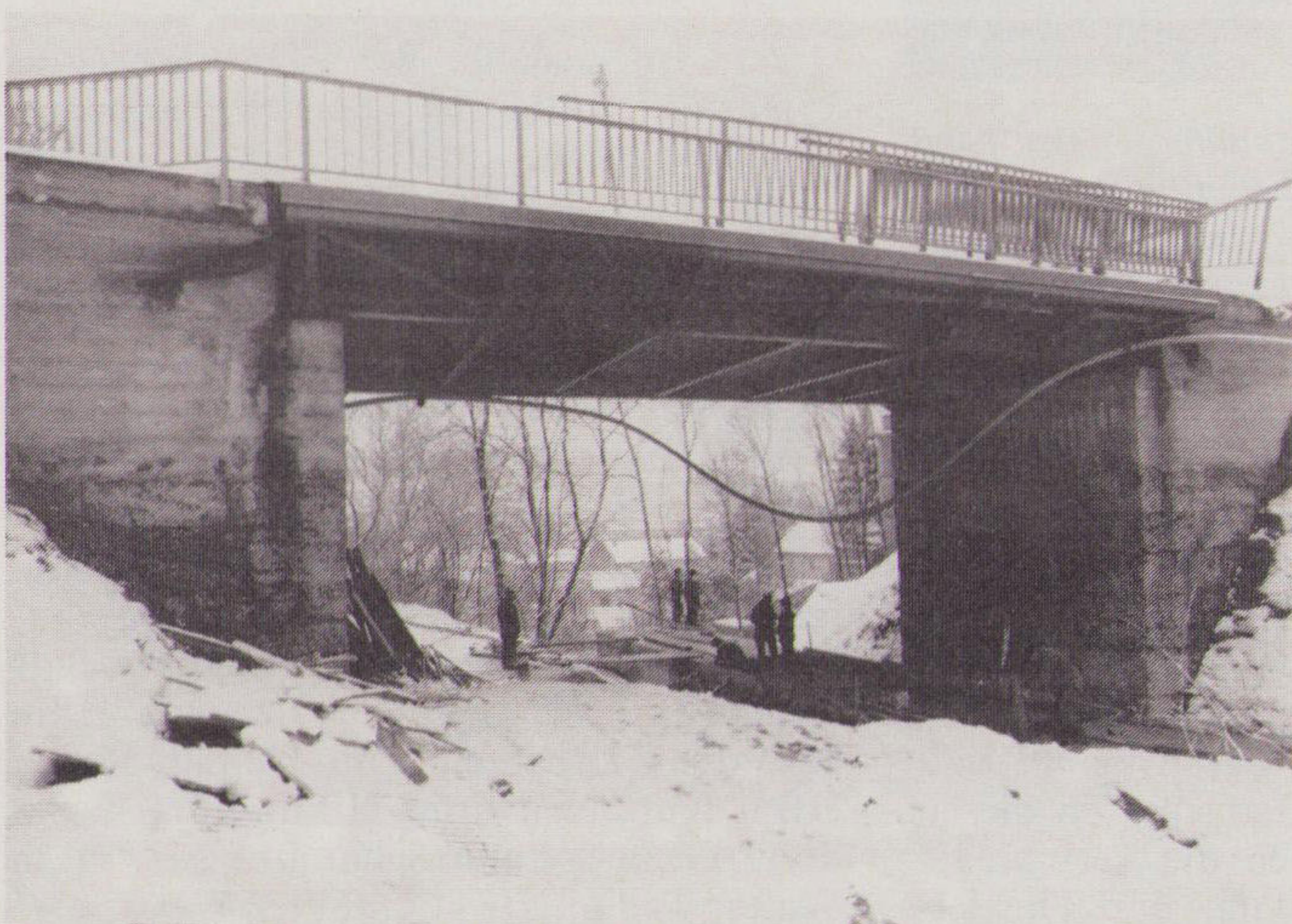
Der Unterlauf des Teufelsbaches mußte zur Herstellung der Fußgeherunterführung verrohrt werden.
