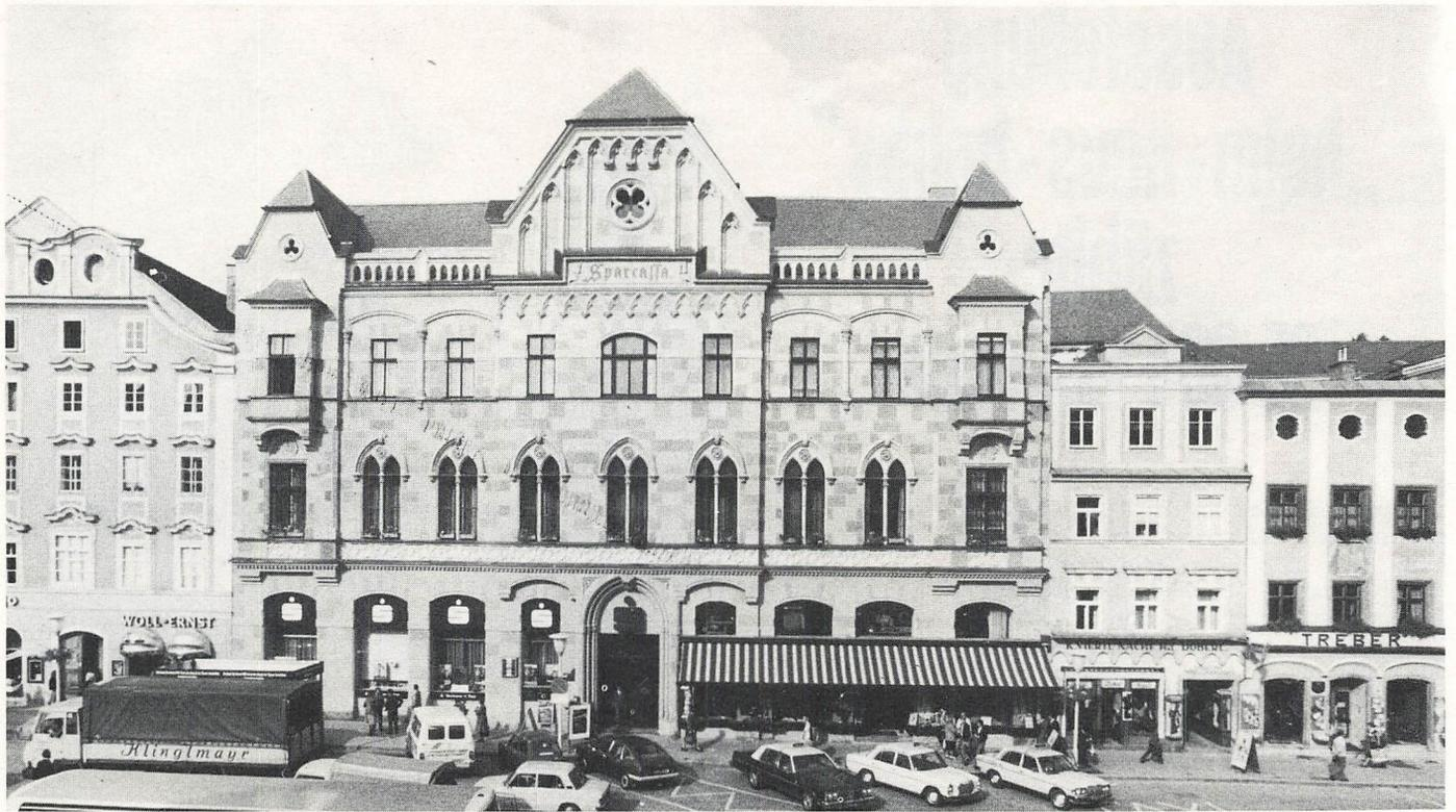
Die Renovierung der Fassade des Sparkassengebäudes am Steyrer Stadtplatz ist großartig gelungen: Mit Sandstrahlgebläse wurde die Schmutzschicht abgetragen – sichtbar geworden ist nun wieder die Schönheit des ursprünglichen Putzes mit den reizvollen Farbkontrasten. Auf der gereinigten Fassade kommen die neugotischen Architekturelemente gut zur Wirkung und geben dem
