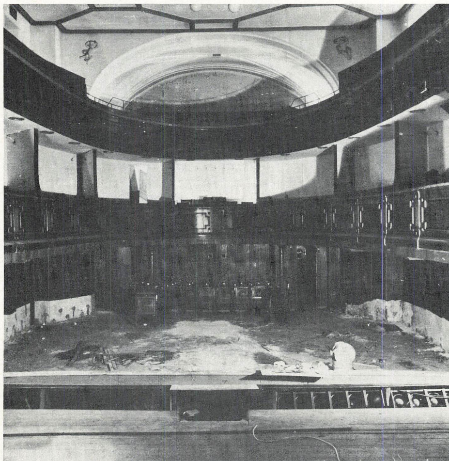
Der Zuschauerraum des alten Stadttheaters vor der Renovierung.
