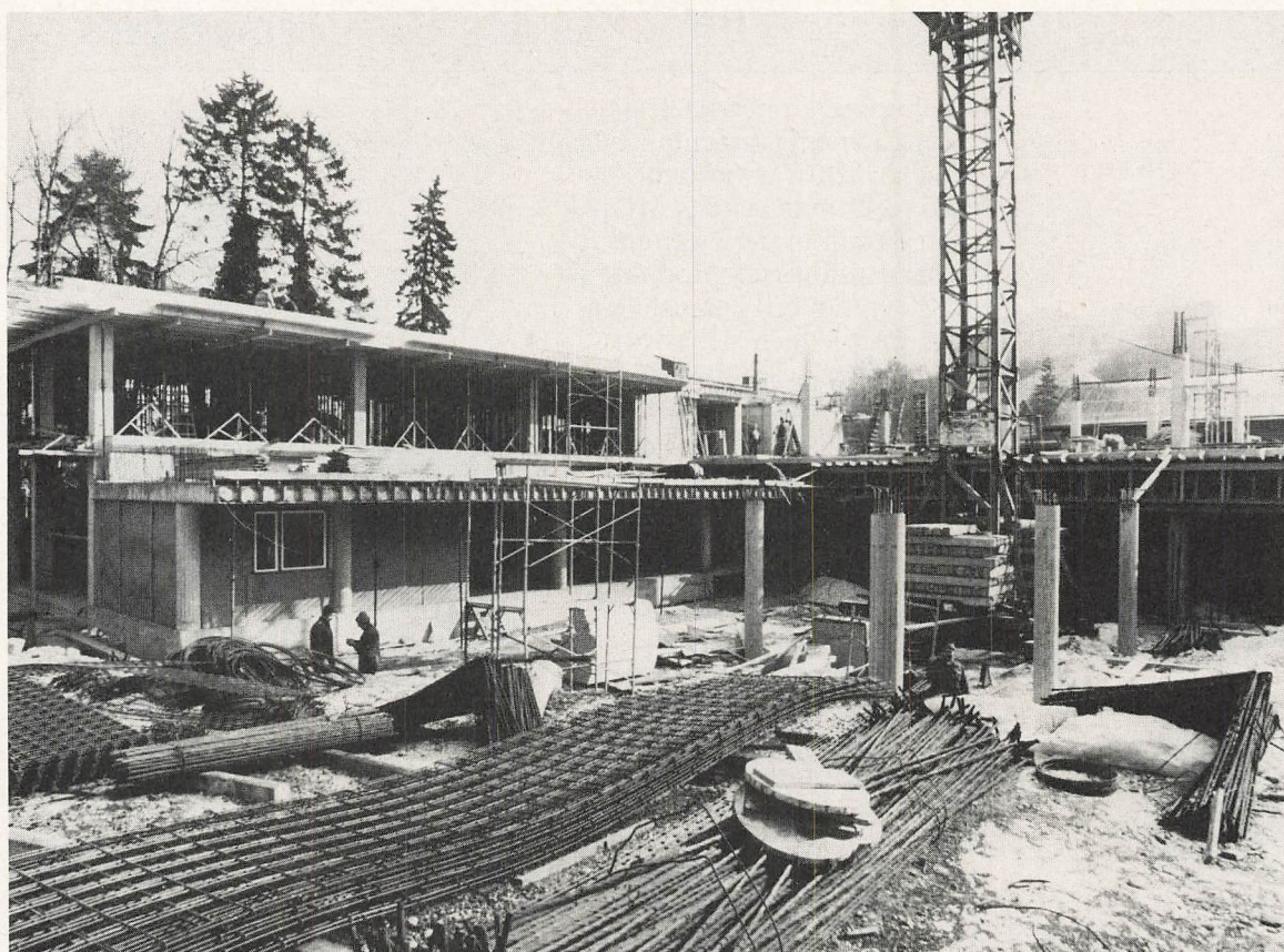
Die Baustelle des Bahnhofpostamtes. Fotos: Hartlauer
