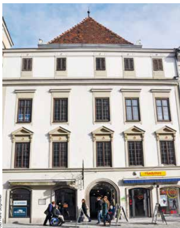
Das Haus Stadtplatz 11/Ennskai 23 – eine im Kern spätgotische Bürgerhausanlage – steht seit 20. April 1990 unter Denkmalschutz.
