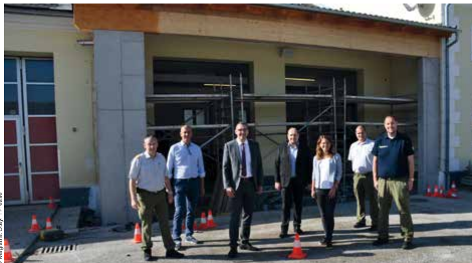
Besuch auf der Baustelle beim Technischen Zug – von links: Bezirksfeuerwehrkommandant Gerhard Praxmarer, Dzevad Kaltak (Mayr Bau GesmbH), Stadtchef Markus Vogl, Matthias Winkler vom Bauamt des Magistrates, Vizebürgermeisterin Anna-Maria Demmelmayr, Ari Hahn (stv. FF-Kommandant), Zugskommandant Markus Schaumberger.
