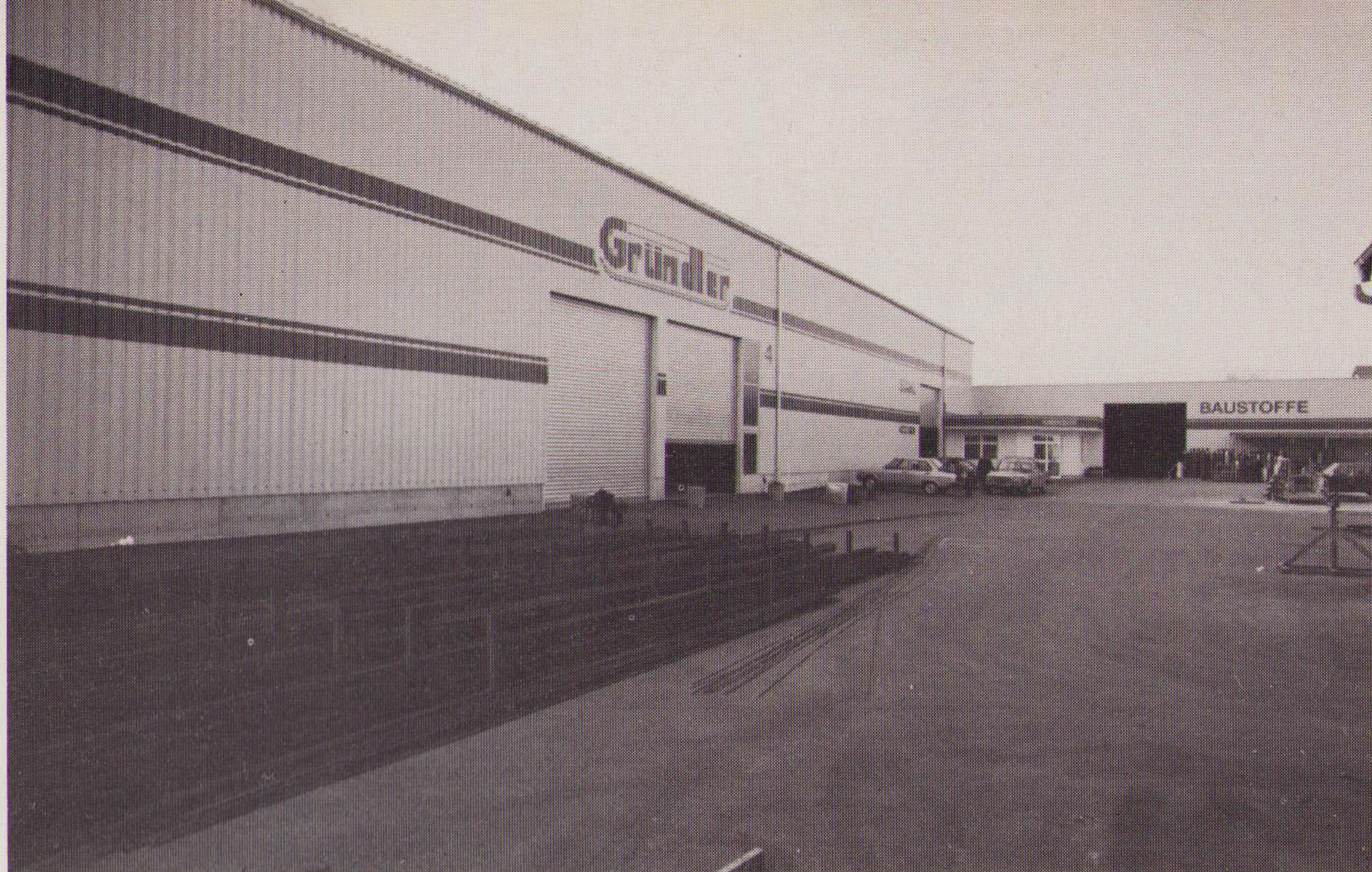
Die neue Stahlhalle der Firma Gründler.
