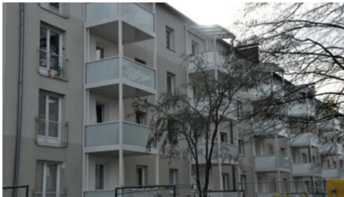
Die etwa 40 angebauten Balkone an den GWG-Wohnhäusern Hafnerstraße 7, 9 und 11 im Stadtteil Ennsleite sind vor kurzem fertig geworden. Mit dieser Maßnahme hat die GWG die Wohnqualität für ihre Mieterinnen und Mieter wesentlich erhöht.
