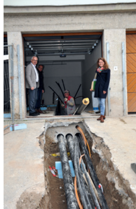
Die Fernwärmeleitung wurde bereits ins Rathaus verlegt – im nächsten Winter wird hier anstelle von Öl mit Wärme aus Biomasse geheizt.
