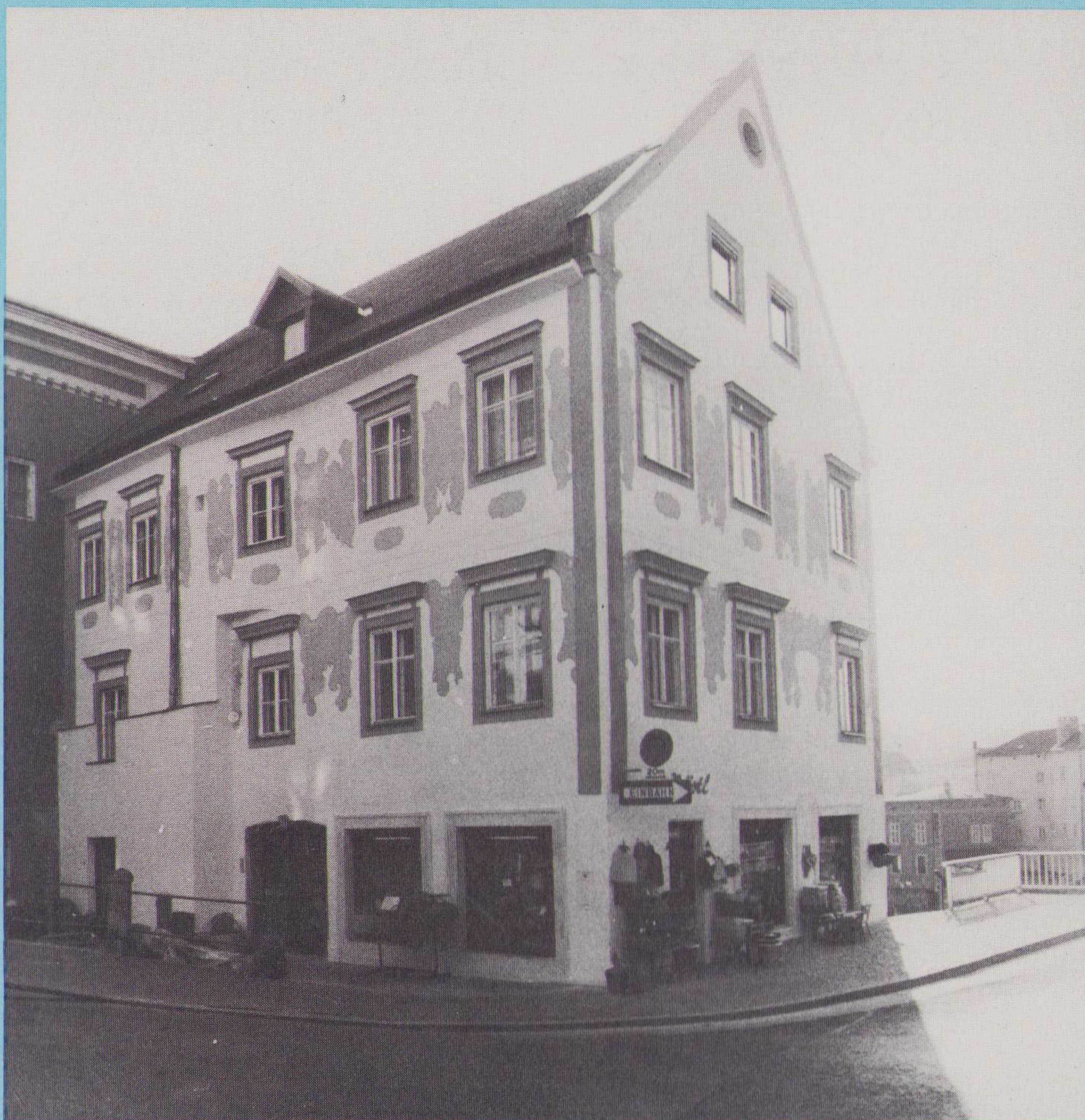
Frühbarocke Architekturmalerei in Weiß und Rosa schmückt nun das Haus Michaelerplatz 14 (im Bild oben das Gebäude vor der Restaurierung). Die Fenster wurden mit Putzumrandungen versehen. Im Erdgeschoß sind noch Portalgestaltungen vorgesehen.
