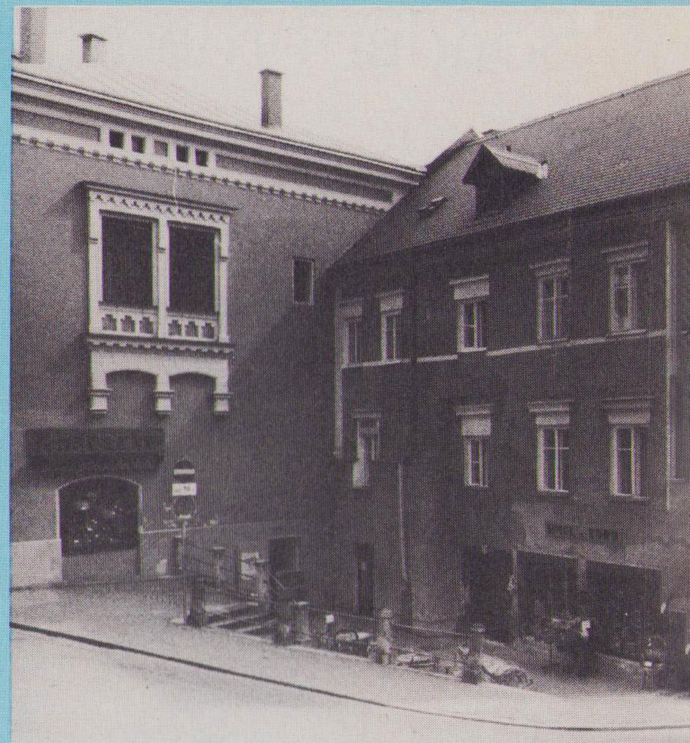
Frühbarocke Architekturmalerei in Weiß und Rosa schmückt nun das Haus Michaelerplatz 14 (im Bild oben das Gebäude vor der Restaurierung). Die Fenster wurden mit Putzumrandungen versehen. Im Erdgeschoß sind noch Portalgestaltungen vorgesehen.
