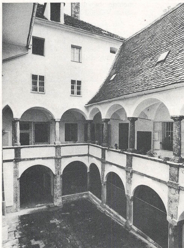
Der Arkadengang im Landsiedl-Hof. Säulen und die dahinter liegenden Fenster und Türgewände sind aus Konglomerat.
