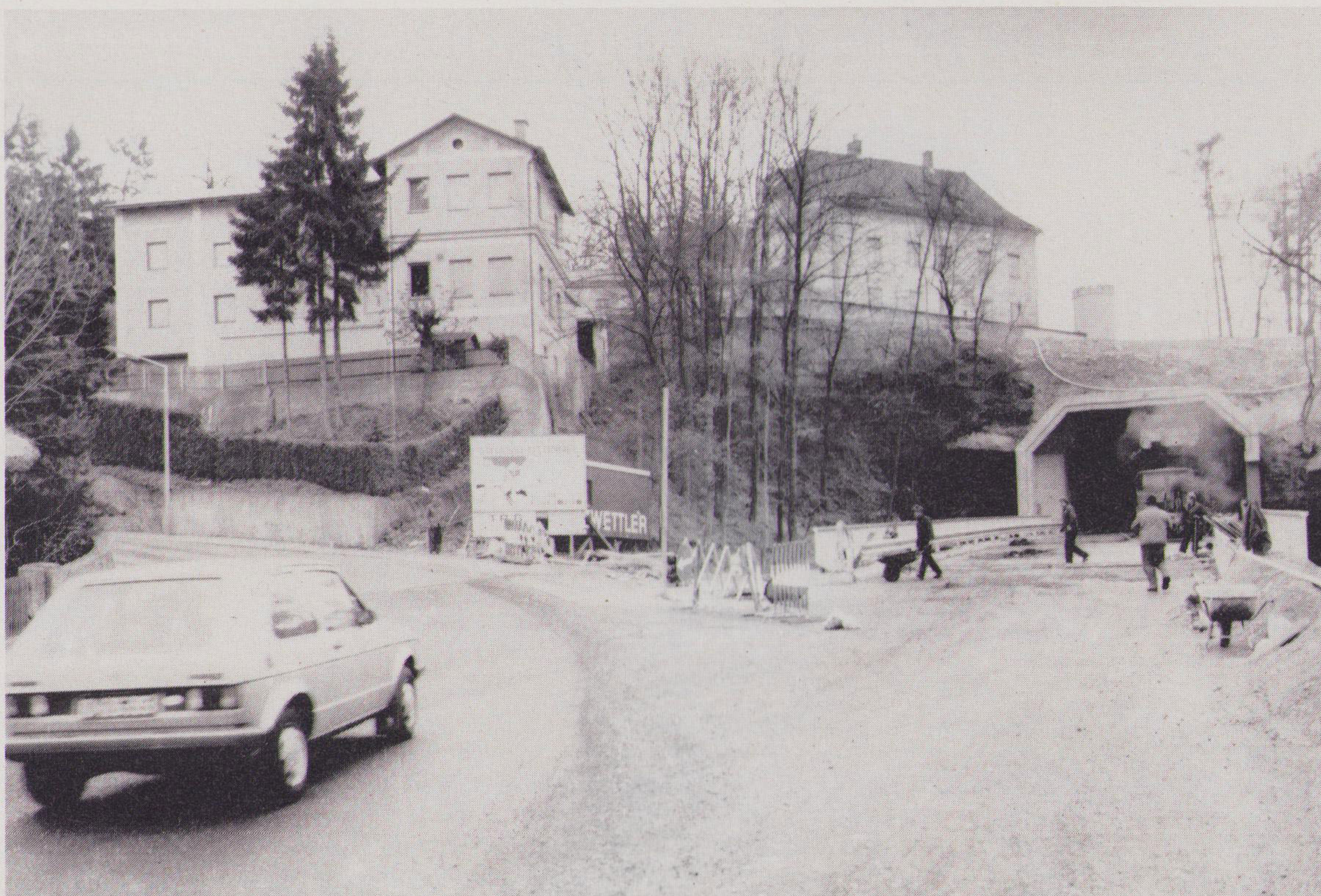
Die neue Straßenverbindung drei Wochen vor der Fertigstellung. Das Bild zeigt die Einbindung der neuen Straße in den Leitnerberg. Foto: Kranzmayr
