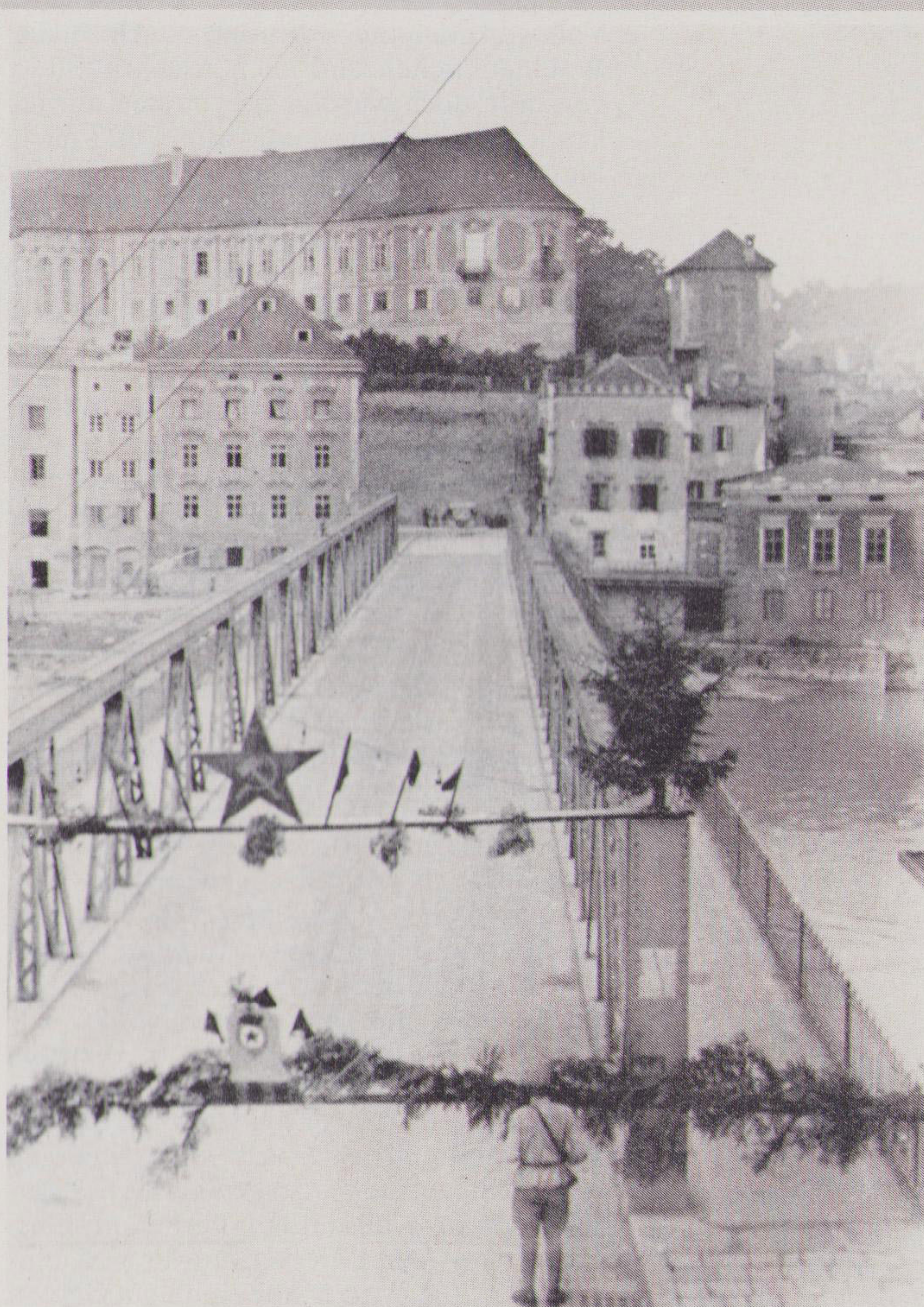
Blick über die gesperrte Ennsbrücke auf das Schloß Lamberg.
