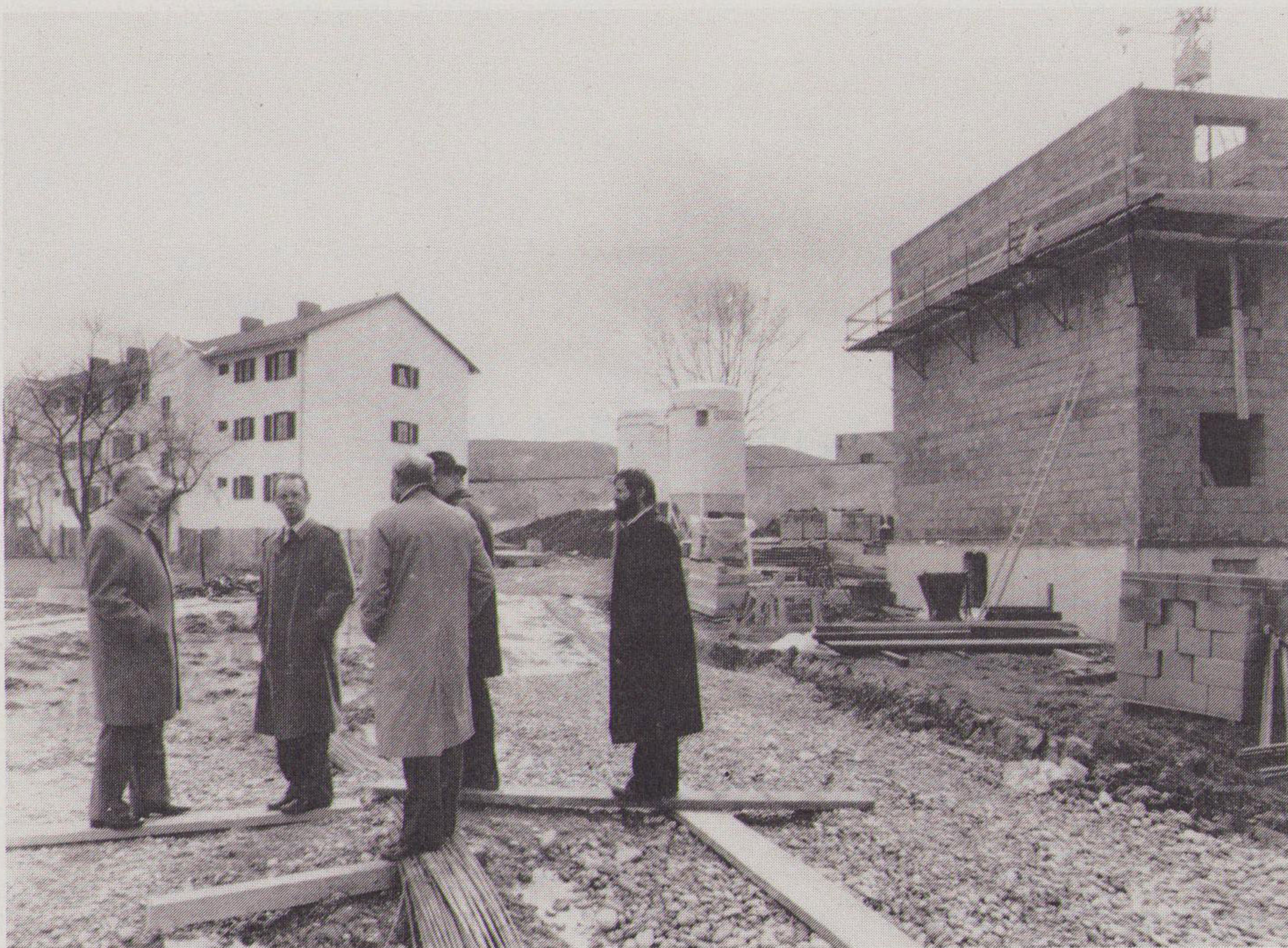
Bürgermeister Schwarz informierte Landesrat Neuhauser über den Fortschritt des Wohnbaues in Steyr. Im Bild die Baustelle Reithoffergasse, wo in der ersten Bauetappe derzeit zwölf Wohnungen fertiggestellt werden.
