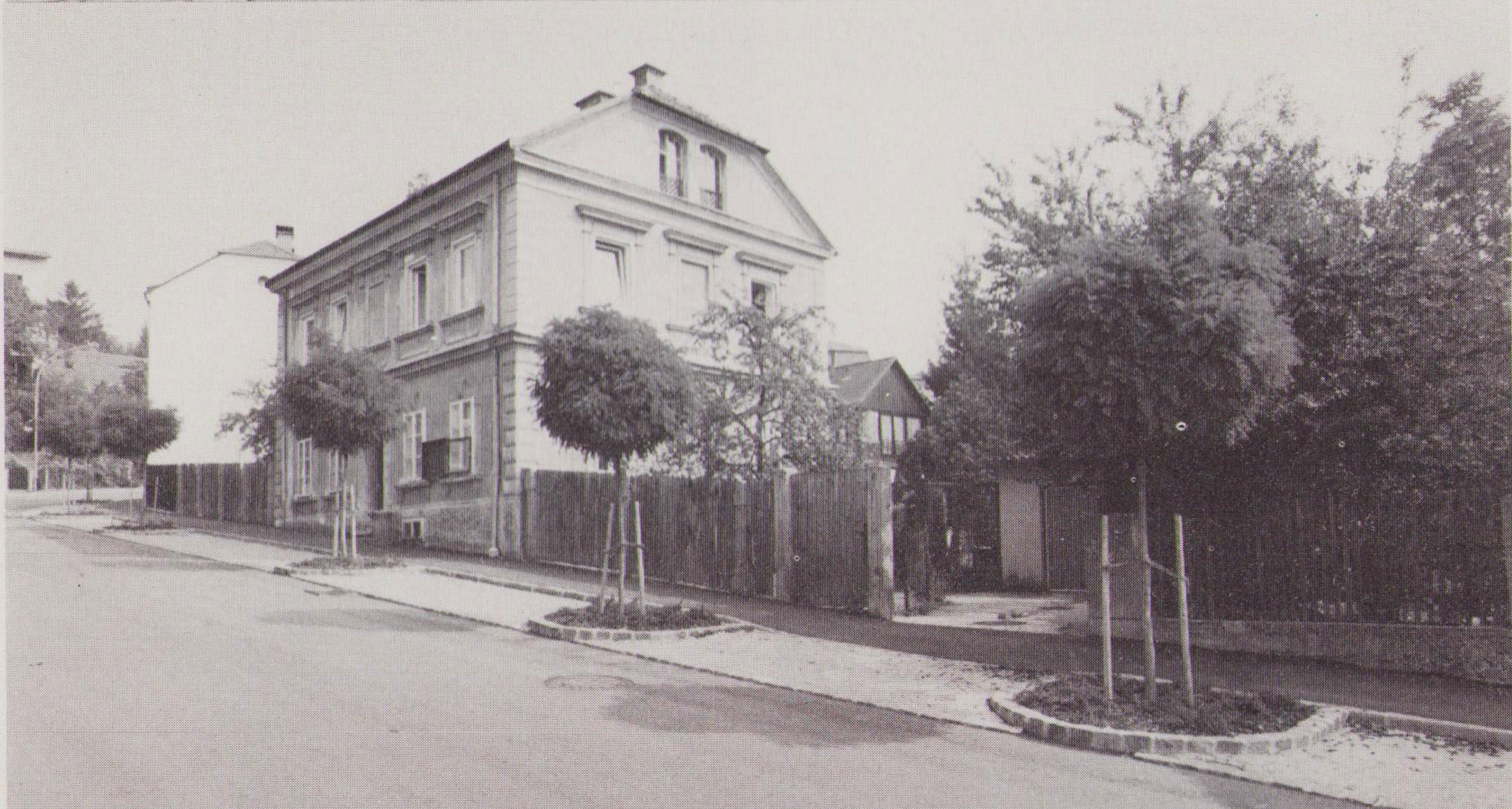
Blick auf den neu gestalteten Direktionsberg, dessen Fahrbahn rückgebaut wurde. Der gewonnene Bereich wurde mit Bäumen und Pflaster neu gestaltet.
