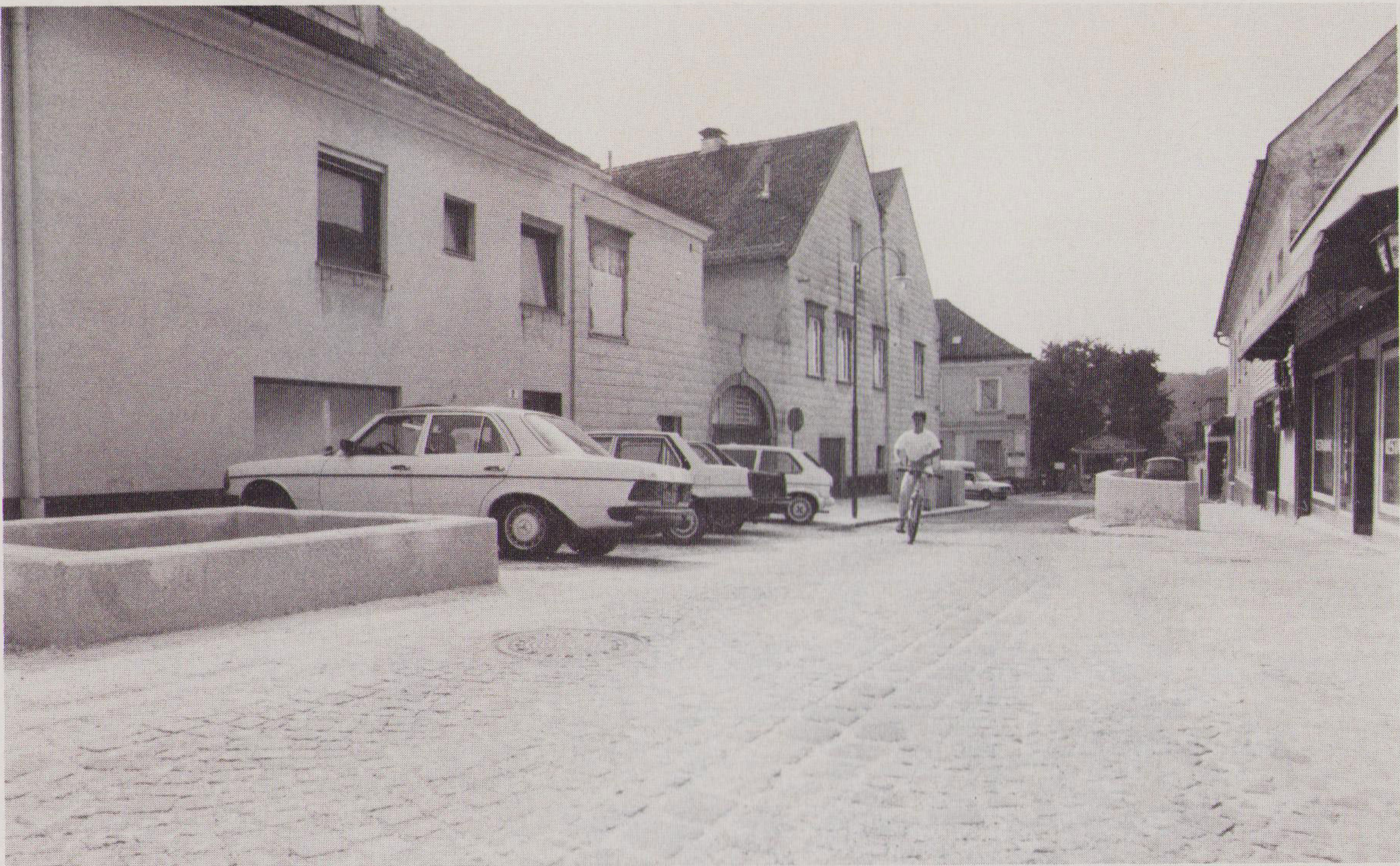
Die Frauengasse im Stadtteil Steyrdorf wurde völlig neu gestaltet. Der mittlere Bereich (im Bild vorne) wurde angehoben und gepflastert. Die Fahrbahn wurde zugunsten der Gehbereiche durch Flügelmauern eingeengt. Links im Bild die quadratische Einfassung, in die heuer noch als optischer Schwerpunkt ein großer Baum gesetzt werden wird.
