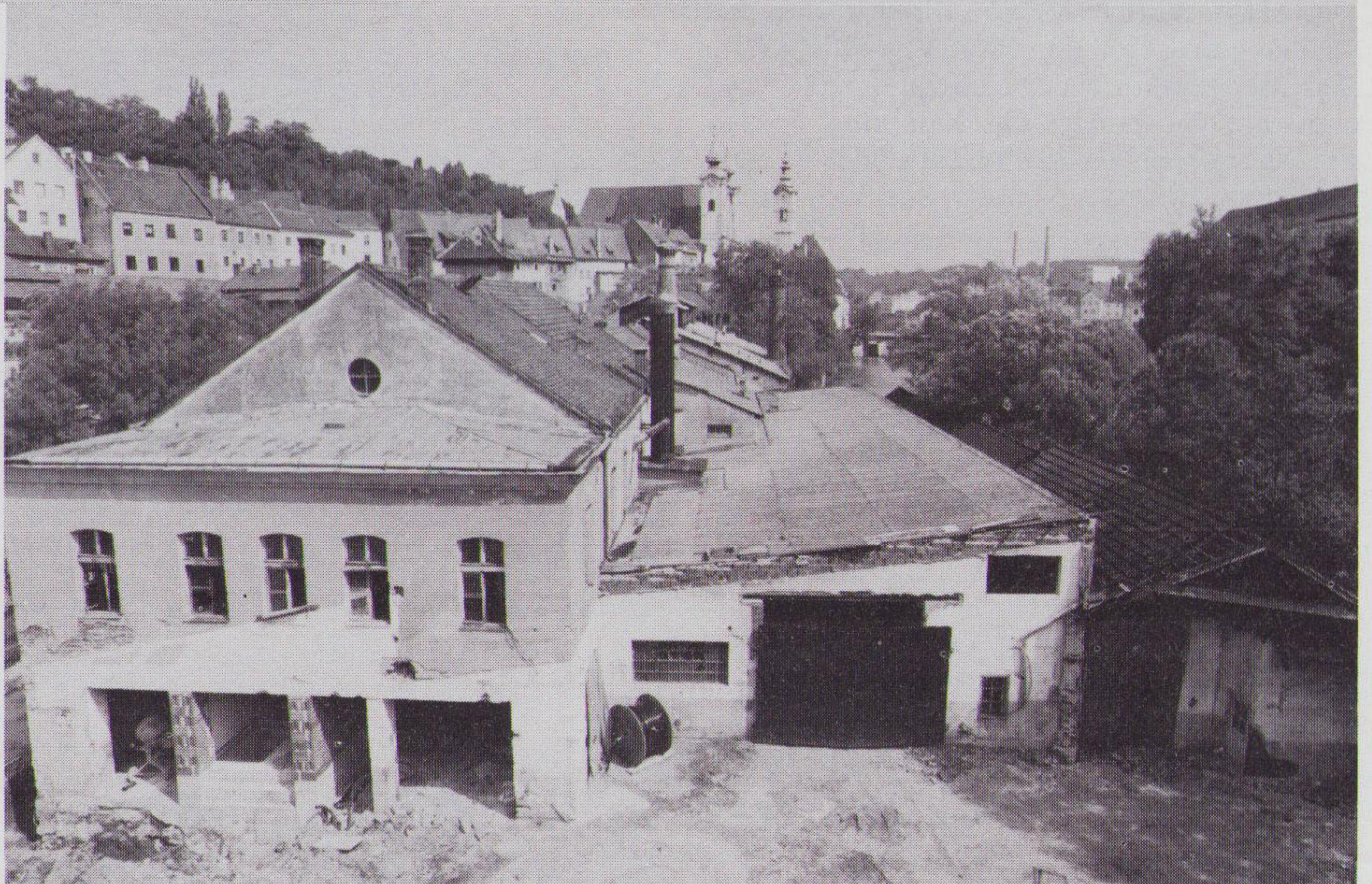
Die flußabwärts gelegenen Altbauten werden in den kommenden Jahren revitalisiert.
