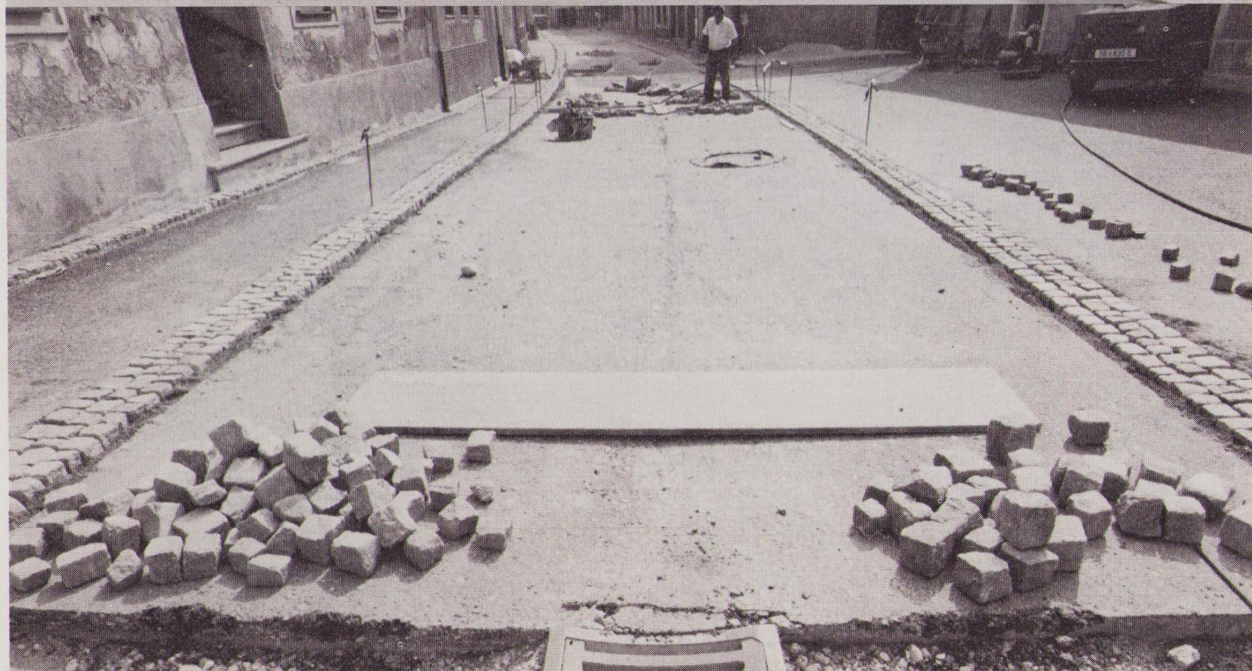
Neugestaltung der Sierninger Straße: Optische Trennung von Fahrbahn und Gehsteig durch Pflastersteine.
