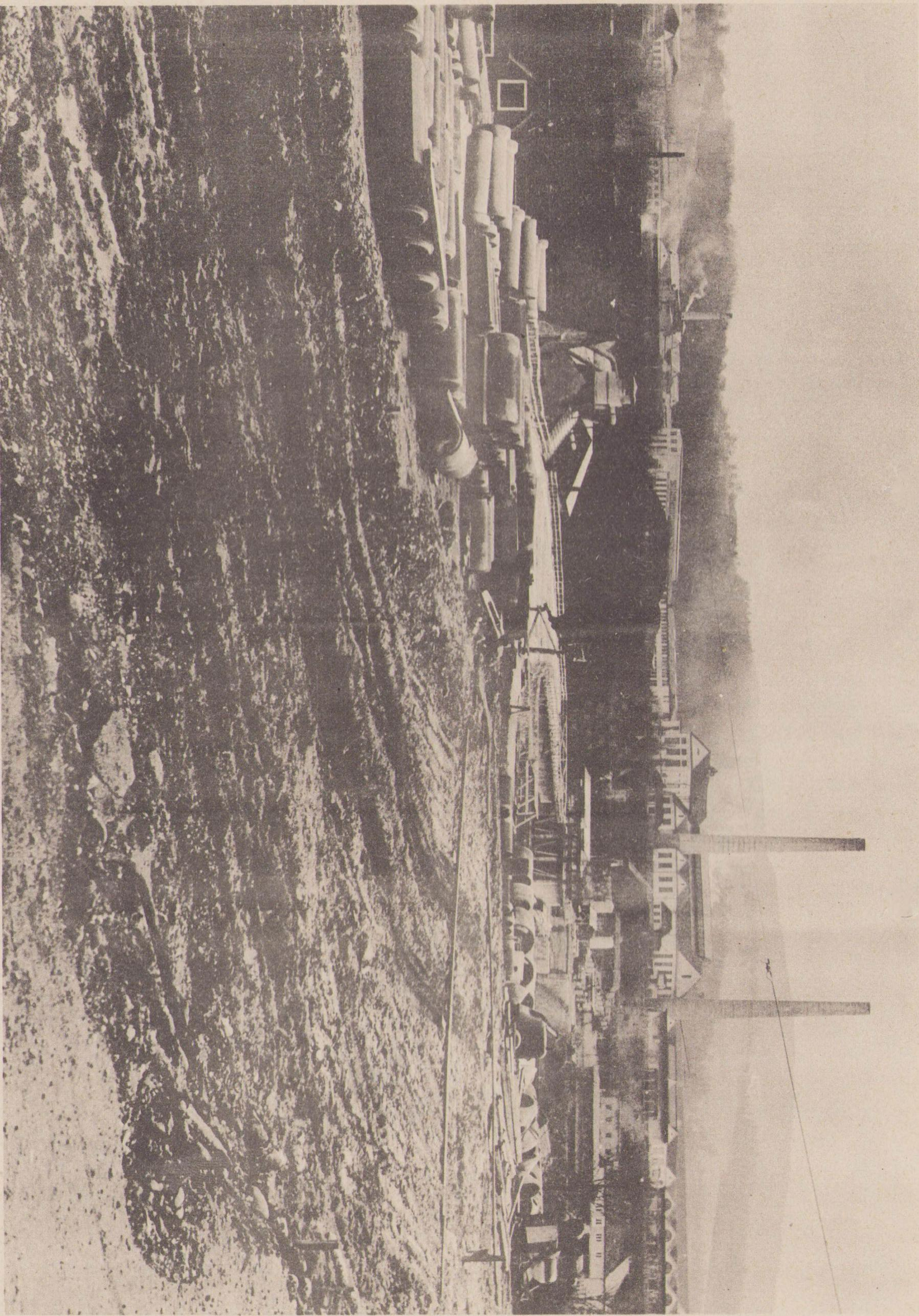
DER AUSBAU DES LINKEN BRÜCKENKOPFES DER NEUEN ENNSBRÜCKE ERFORDERTE UMFANGREICHE ERDBEWEGUNGEN; FÜR LÄNGERE ZEIT MUSSTE DAHER DIE SCHLÜSSELHOFGASSE BEIM GASTHAUS KOBLMÜLLER GESPERRT WERDEN. (SIEHE ARTIKEL IM INNEREN DIESES AMTSBLATTES).
